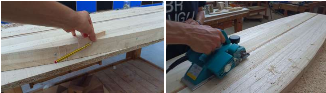
Figura 40: Marcant el límit per la polidora (esquerra) i utilitzant el ribot elèctric (dreta) (elaboració pròpia).
