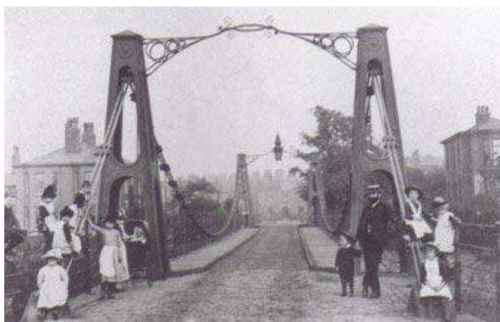
Figura 2.11: Pont de Broughton abans d'enfonsar-se a causa de la ressonància. (Font: Puente de Broughton // Historias de un científico).
