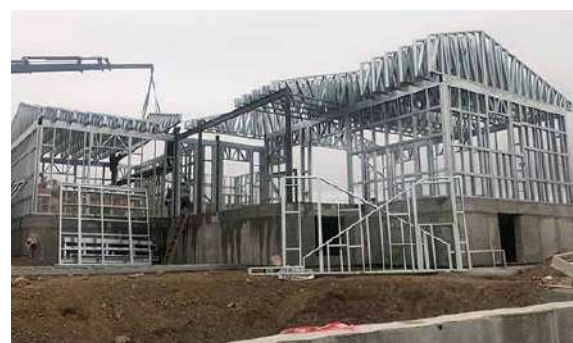
Fig. 17 Font: Steelframing.es. Steel Frame.
