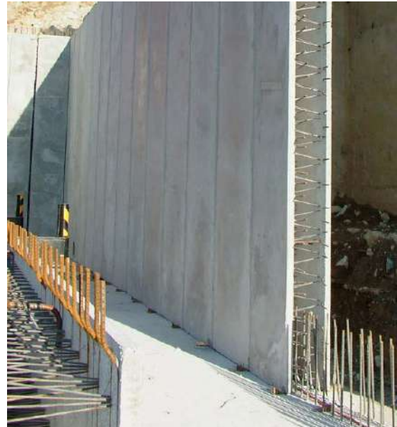
Fig. 19 Font: Prefabricados Agustín. Muro homigón armado.
