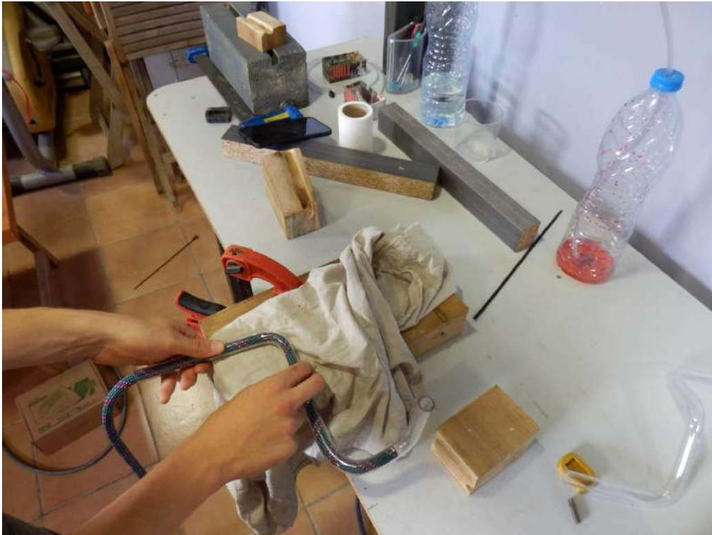
Imatge 106: Refredant el tub amb el drap mentre s'acaba d'ajustar la curvatura del tub després de passar-lo per el motlle corresponent.
