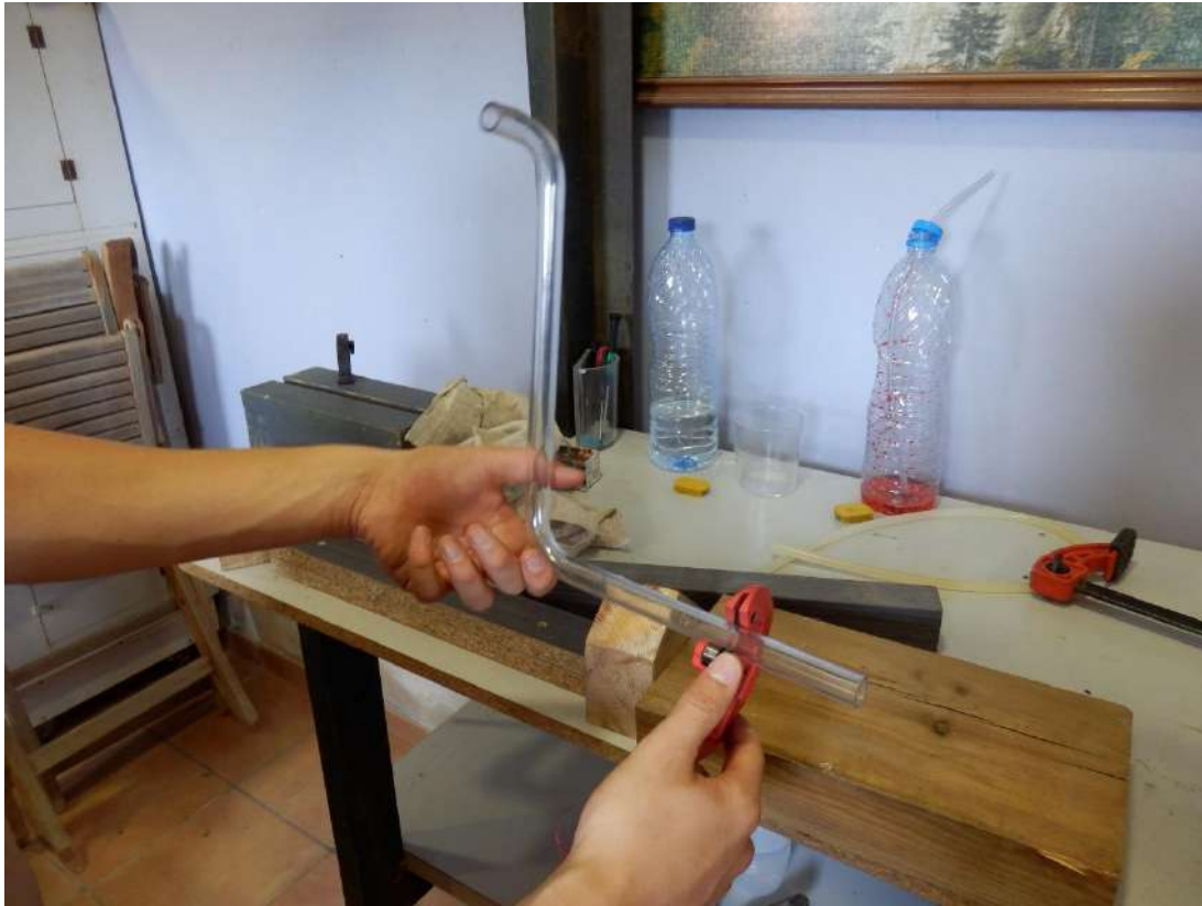
Imatge 107: Tallant el tub en la mida correcta després de modelar-lo en la curvatura correcte.
