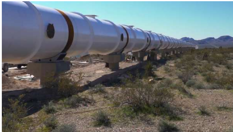
Fig. 24 [23] - Foto del túnel de proves de l'Hyperloop One.
