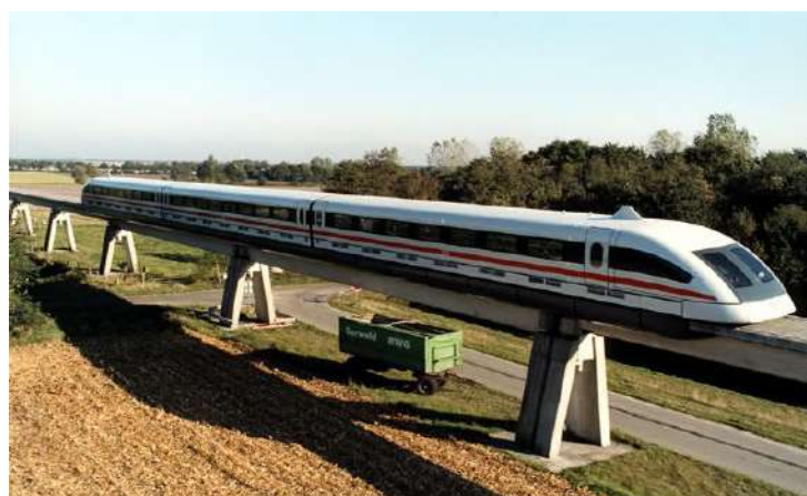
Fig. 12 [11] - Imatge d'un Maglev on es poden apreciar clarament els pilars, que sostenen la via, en forma de "V" invertida
