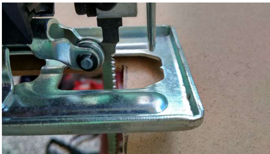
Fig. 41- Tallant la fullola per la caixa de connexions amb una serra.
